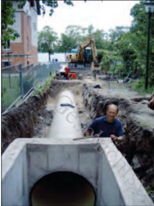
Abb. 3: Leitungsverlegung an der Wasserpforte. Im Vordergrund Grabungsleiter U. Wiegmann.
