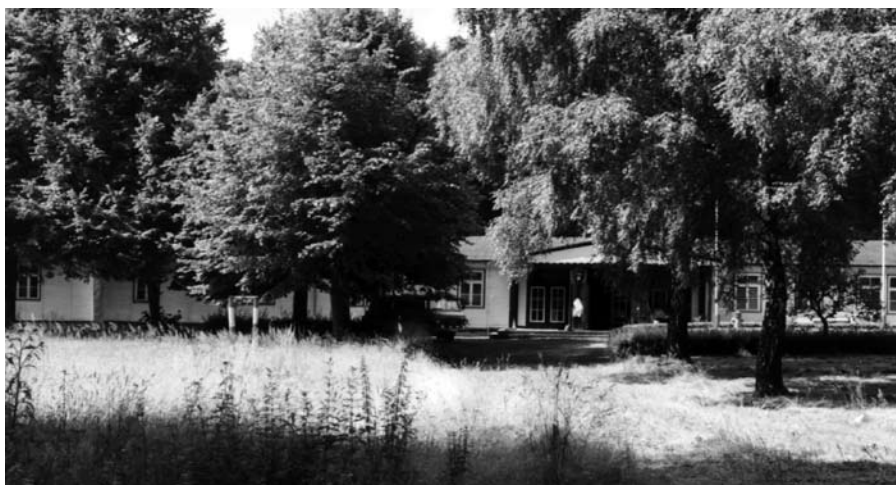
Abb. 3 Baracke mit Versorgungsfahrzeug B 1000
