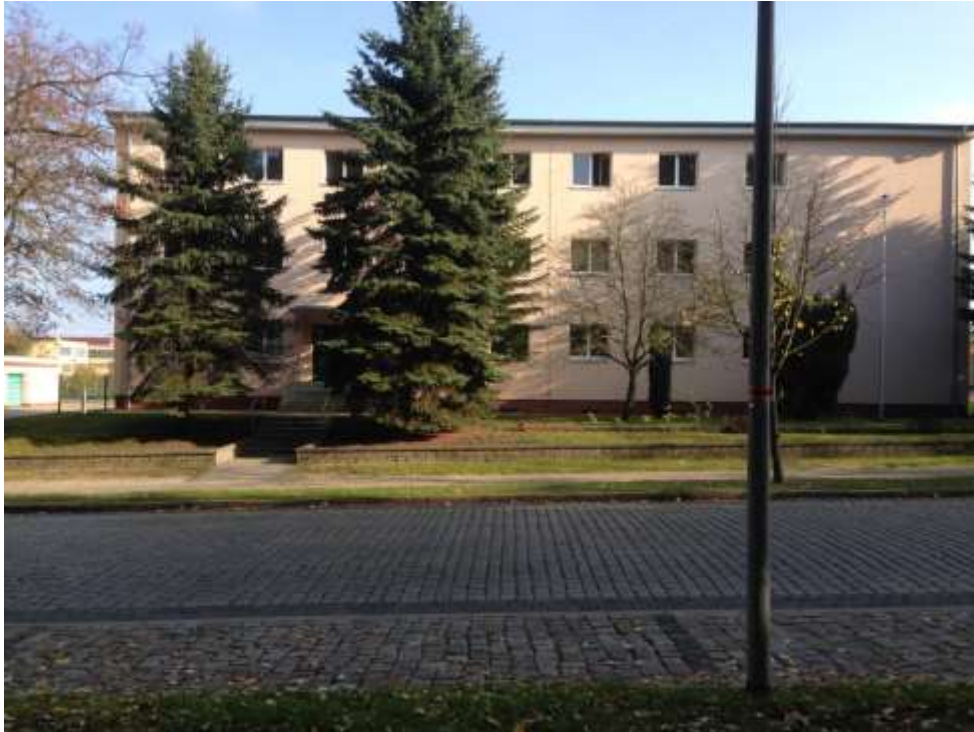
Anlage 2, ehemalige Kreisdienststelle Prenzlau in der Grabowstraße 33
