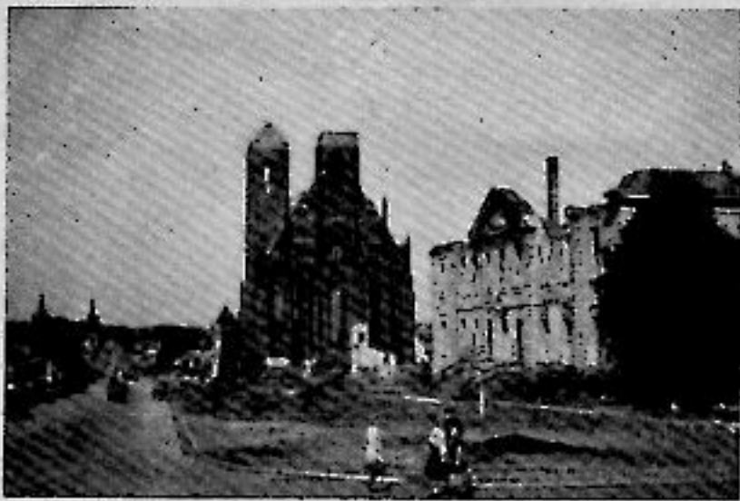
Blick über den zerstörten Markt nach Westen.
