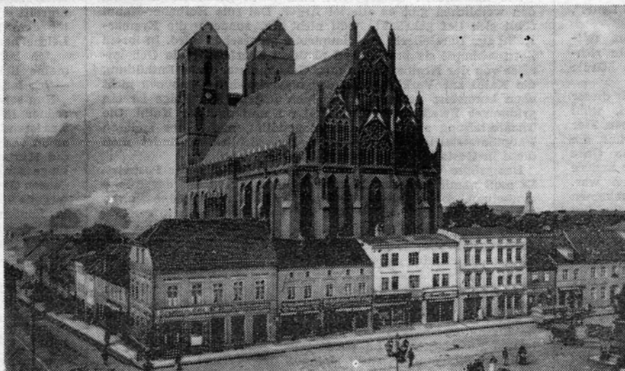
Die St.-Marien-Kirche in Prenzlau zählte zu den stolzesten Backsteinbauten im nord-deutschen Raum. Im Jahre 1945 wurde sie vollständig zerstört. (Leihgabe: Pastor Gueffroy)
